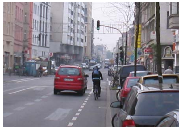
Schutzstreifen nach Ummarkierung auf einer vorhandenen Fahrbahn
